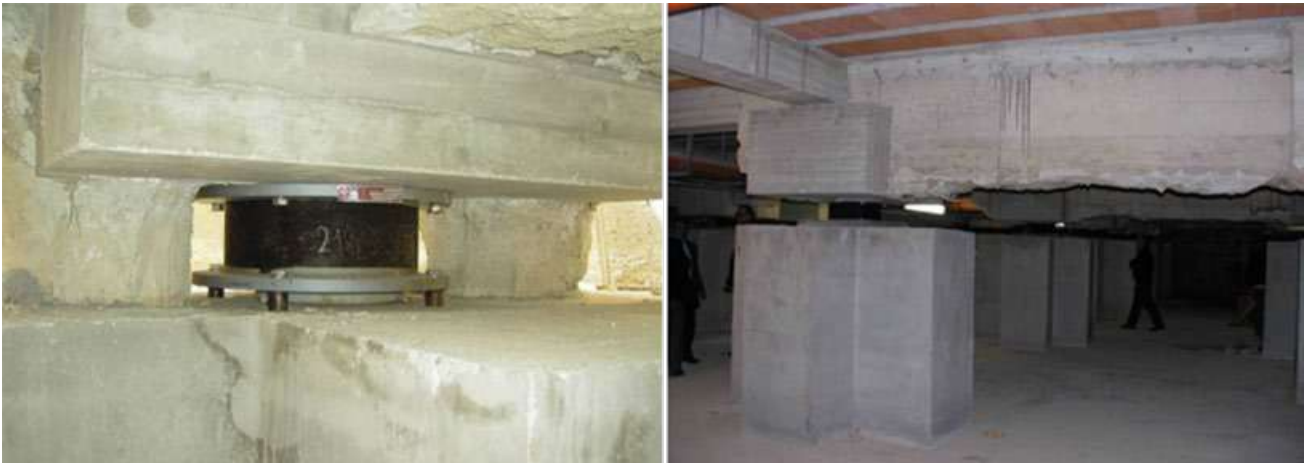
Figura 2 - Edifici via Latini, Fabriano: messa a nudo delle fondazioni preesistenti, nuove fondazioni, Isolatore collocato tra il plinto preesistente (superiore) e il pilastro di nuova realizzazione (inferiore), con martinetto al di sotto per la messa in carico, e situazione a lavori ultimati
