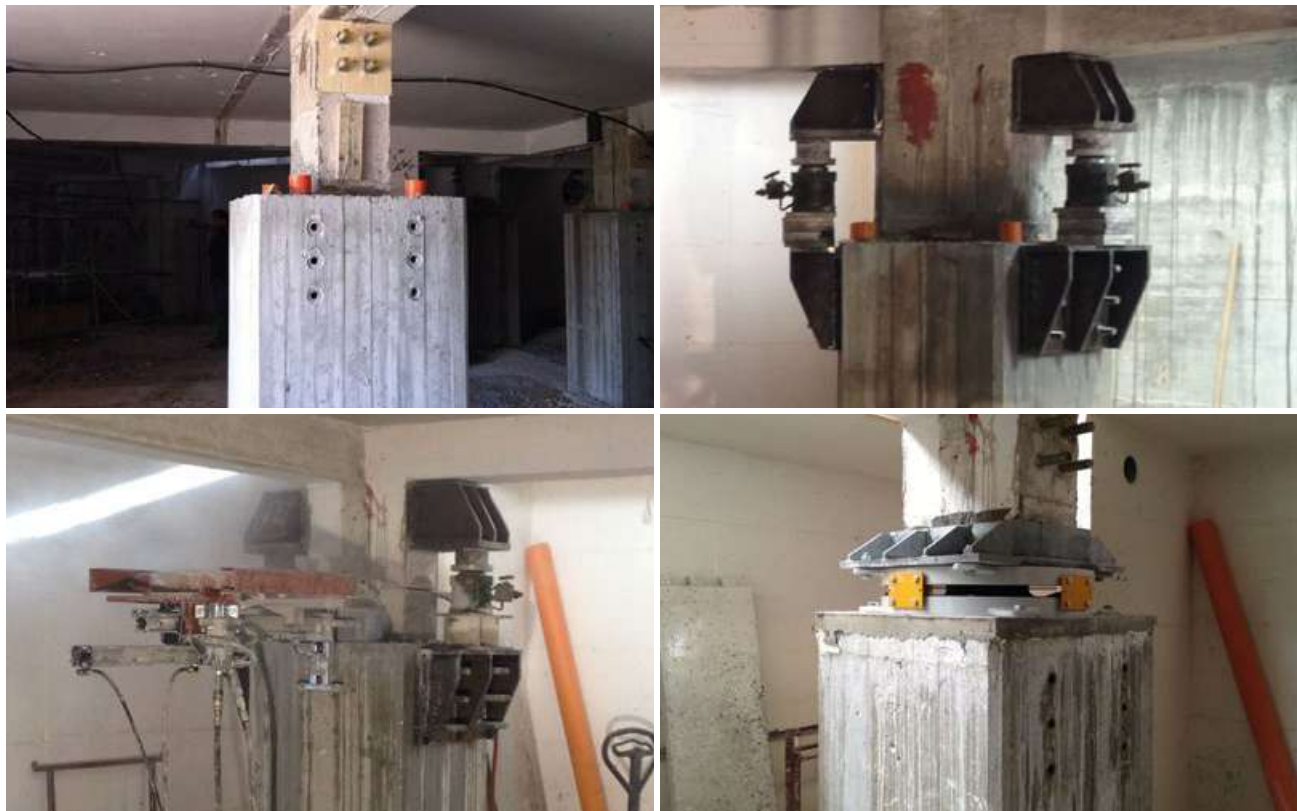
Figura 1 - Condominio Leonardo: ringrosso dei pilastri, predisposizione delle boccole per l'ancoraggio delle mensole inferiori e dei recessi per l'ancoraggio delle zanche inferiori dell'isolatore e installazione delle mensole metalliche e dei martinetti idraulici, taglio con filo diamantato e isolatore alla fine dell'installazione (foto FIP Industriale)
